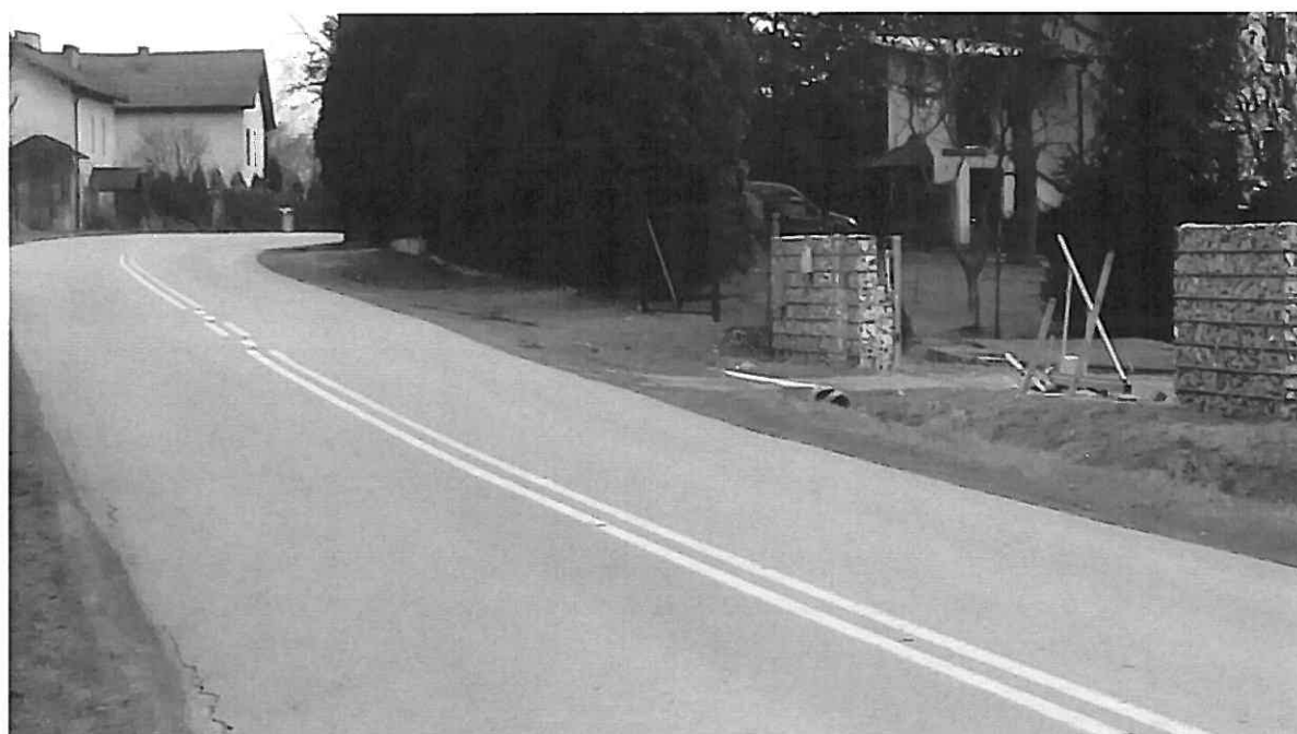
Ogrodzenie po wypadku
